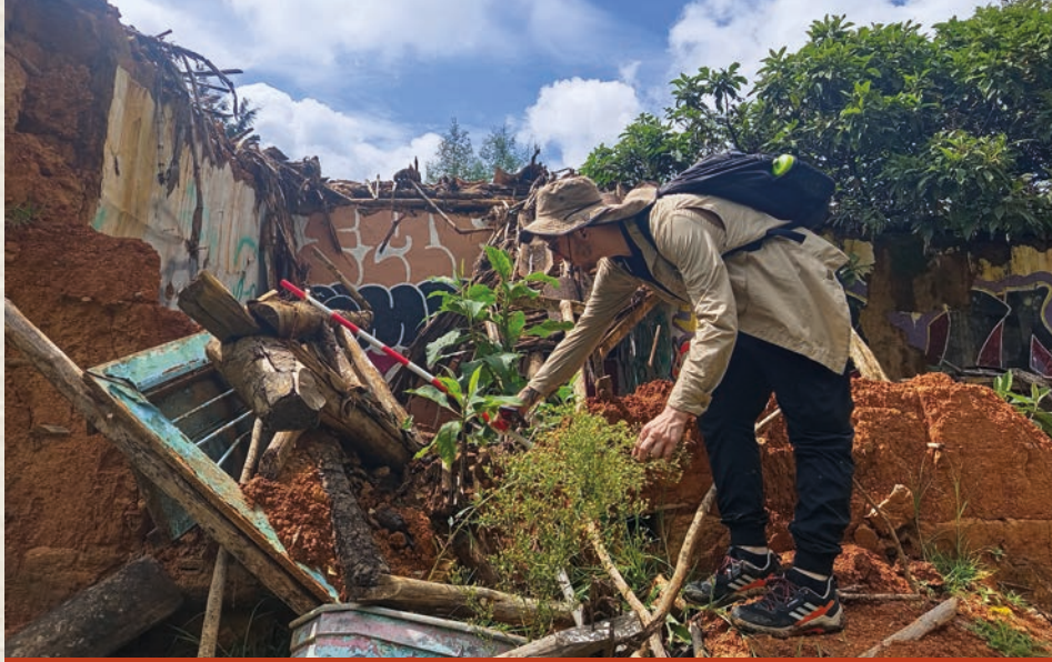
Registro de ruinas en sector Los Vásquez. 2025. Fotografía: equipo Técnico del proyecto.
